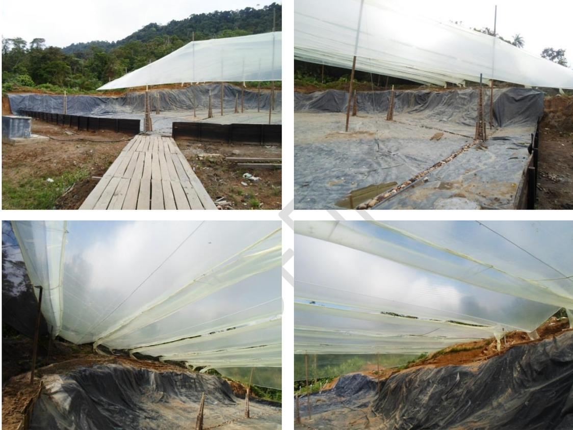
La justificación de mantener la cubierta está direccionada en evitar el contacto directo de los residuos sólidos con el agua lluvia para facilitar la operación del relleno y para disminuir de manera significativa la generación de lixiviados por aguas lluvias.
