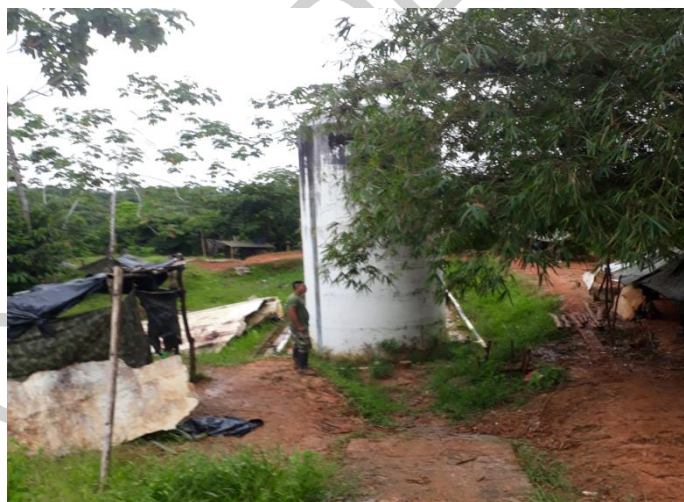
Planta de tratamiento de agua potable- PTAP
