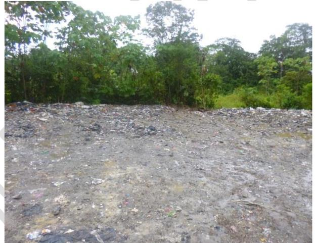
Se pudo evidenciar que el mantenimiento de la celda se realizó con las técnicas adecuadas, frecuencia y el acondicionamiento de los desechos sólidos, encalamiento y cubrimiento con material de playa con un espesor aproximado de 10 centímetros para así evitar la proliferación de moscos e insectos en la zona.
