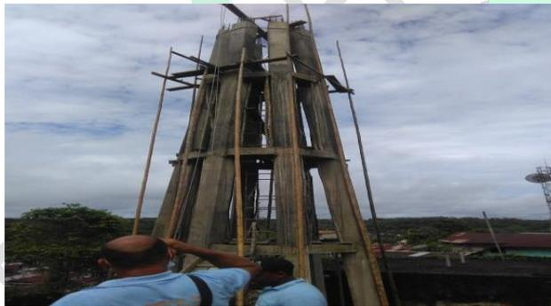
Foto: Construcción tanque de distribución de agua
