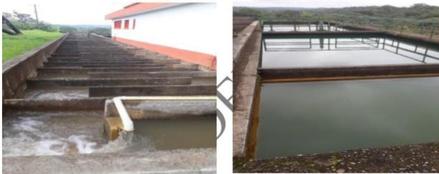
Floculación con sulfato de aluminio- sedimentador
