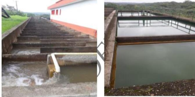
Floculación con sulfato de aluminio- sedimentador
