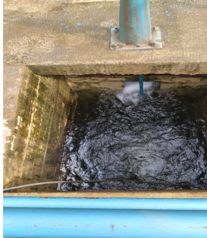
PLANTA DE TRATAMIENTO DE AGUA POTABLE
