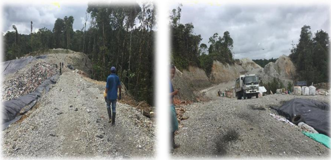
Celda para la disposición de residuos sólidos
