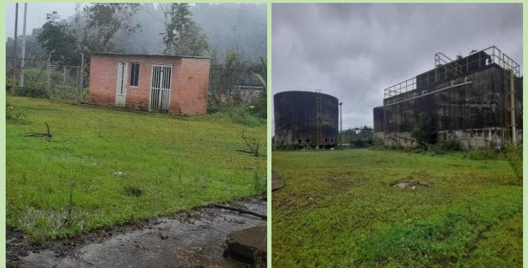
PLANTA DE TRATAMIENTO DE AGUAS RESIDUALES
