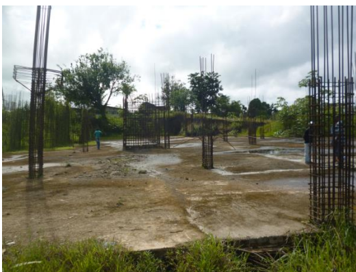
Fig. 3. Hierro armado columna y ascensor (Intemperie)
