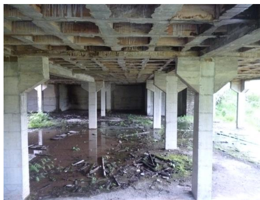
Fig. 4. Sotano No. 02 (Columnas y Losa aligerada)
