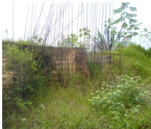
Fig. 2. Hierro figurado para muro perimetral
