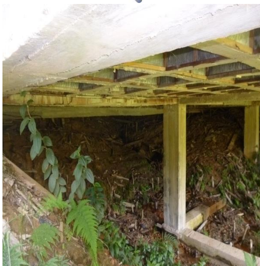
Fig. 5. Sotano No. 03 (Columna y viga de Coronación)
