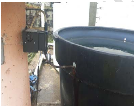
Fotos 3 y 4 - Bombas dosificadoras en regular estado
